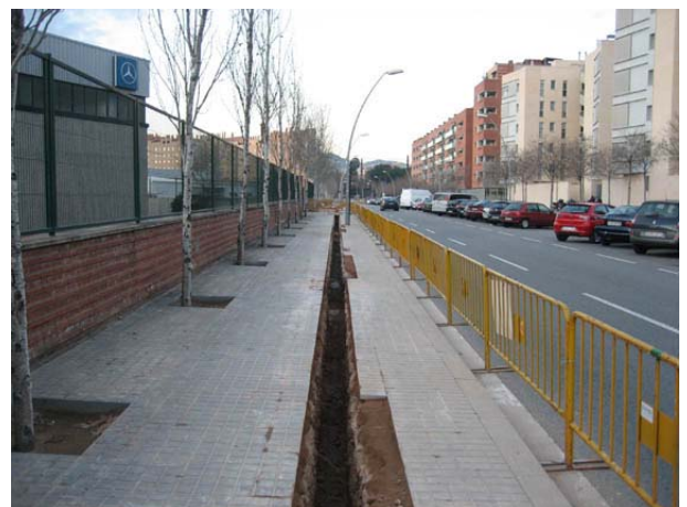
FOTO 4. Vista general del Tram 3.
